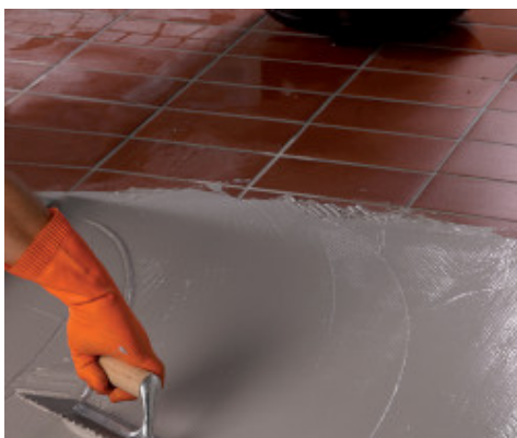
Εφαρμογή της δεύτερης στρώσης Monolastic στο Mape-net 150
