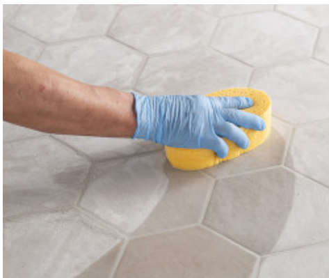
Καθαρισμός και φινίρισμα των αρμών με σκληρό σφουγγάρι κυτταρίνης
