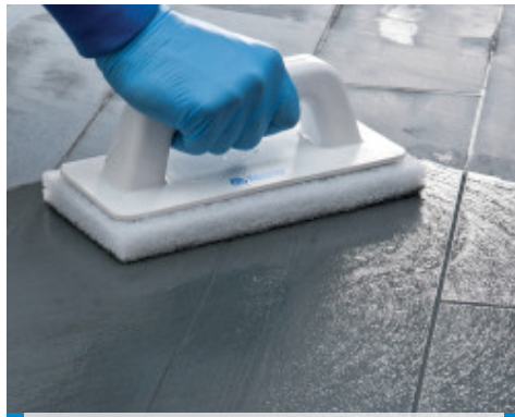
Καθαρισμός αρμών με σφουγγάρι Scotch-Brite® (αφού έχει αρχίσει η σκλήρυνση του αρμόστοκου)
