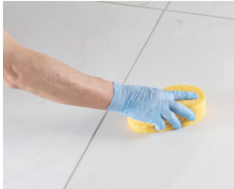
Καθαρισμός και φινιρίσμα του αρμόστοκου με σφουγγάρι κυταρίνης
