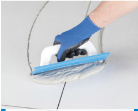
Τοποθέτηση Ultracolor Plus σε δάπεδο με λαστιχένια σπάτουλα σε πλακίδια τεχνητού γρανίτη
