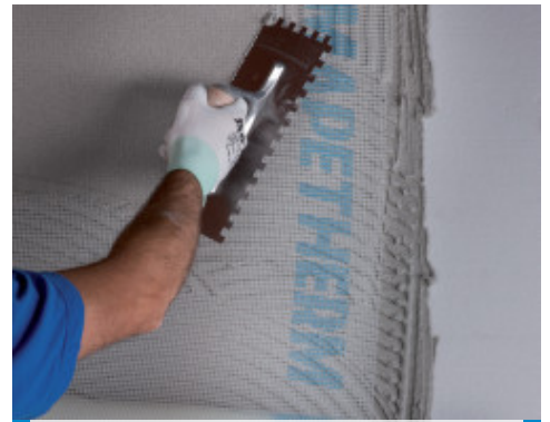
Εφαρμογή εξομαλυντικής στρώσης οπλισμένης με υαλόπλεγμα Mapetherm Net
