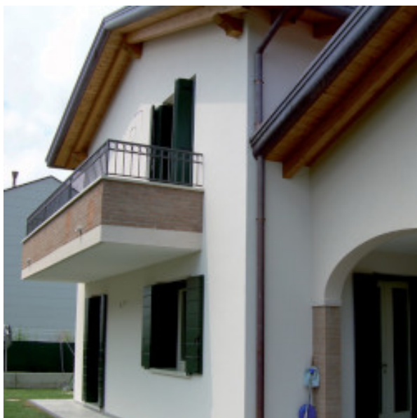
Reggio Emilia - Ιταλία - Εργασίες σε ιδιωτική κατοικία, όπου χρησιμοποιήθηκε το Mapetherm ARI GG
