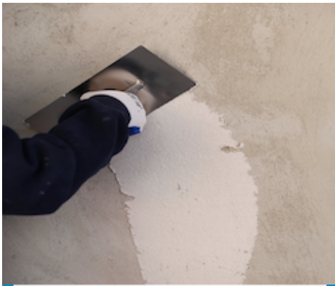
Επισκευή παλιού σοβά με το Intomarp R Fast.
