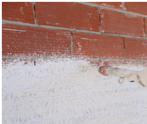
Εφαρμογή Intomar Mono με μηχανή κονιαμάτων
