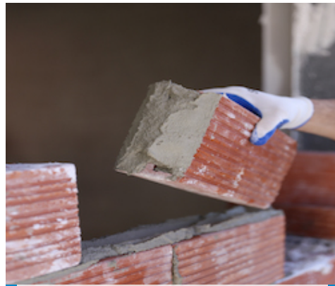
Χτίσιμο τοίχου από τούβλα με Intomarp Build M5.
