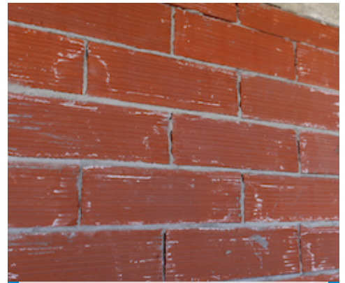
Χτίσιμο τοίχου από τούβλα με Intomarp Build M5.
