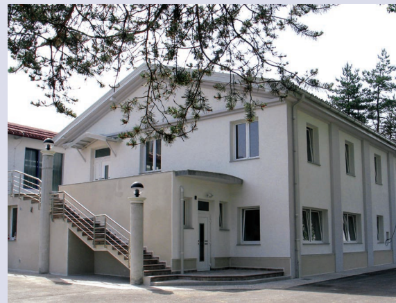
Θερμομόνωση των θερμογεφυρών με FIBRANxps ETICS BT
