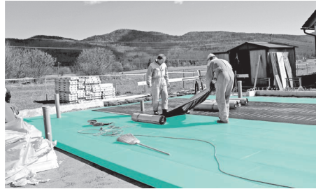
Κατασκευή Βιομηχανικού δαπέδου με FIBRANxps 500
