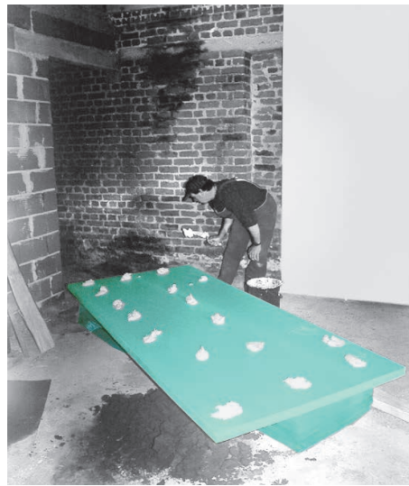
Θερμομόνωση εσωτερικά με FIBRANxps FABRIC σε συνδυασμό με γυψοσανίδες
