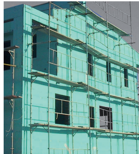
Εξωτερική θερμομόνωση με FIBRANxps ETICS GF
