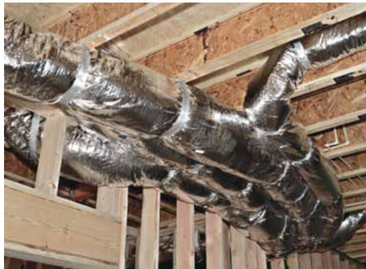
Θερμομόνωση σωληνώσεων με FIBRANgeo R-040-AL
