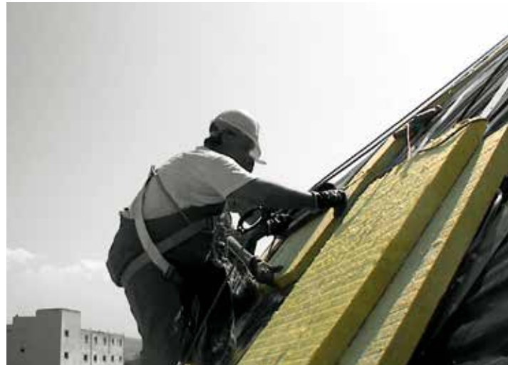
Θερμομόνωση κεκλιμένης στέγης μεταξύ δυο μεταλλικών φύλλων επιστέγασης με διπλή στρώση πετροβάμβακα FIBRANgeo BP-40 και BP-50
