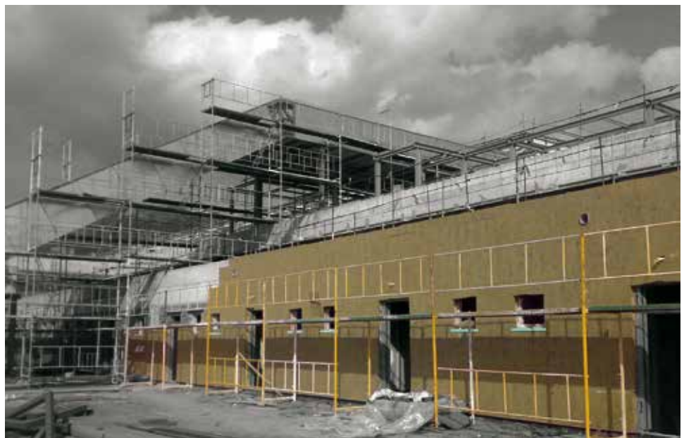
Θερμομόνωση μεταλλικών φύλλων πλαγιοκάλυψης
